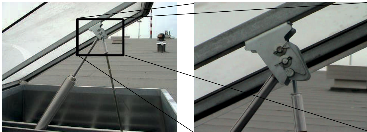
Рис. 24. Під'єднання приводів до гачкової консолі.
