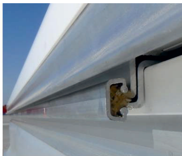
Рис. 21. Петля з змонтованим з'єднанням
