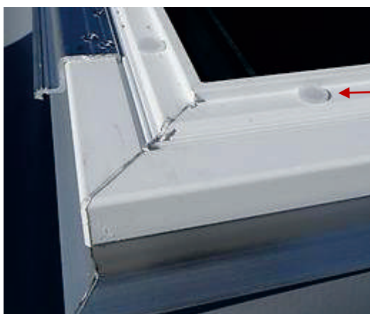
Рис. 12. Монтаж заглушок на притискній рамі з ПВХ.
