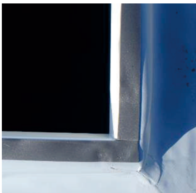
Рис. 9. З'єднання ущільнення PES в кутах
