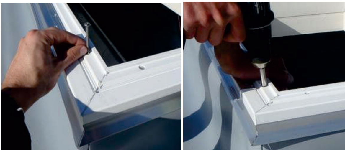
Рис. 11. Прикріплення притискної рами з ПВХ до металевої основи
