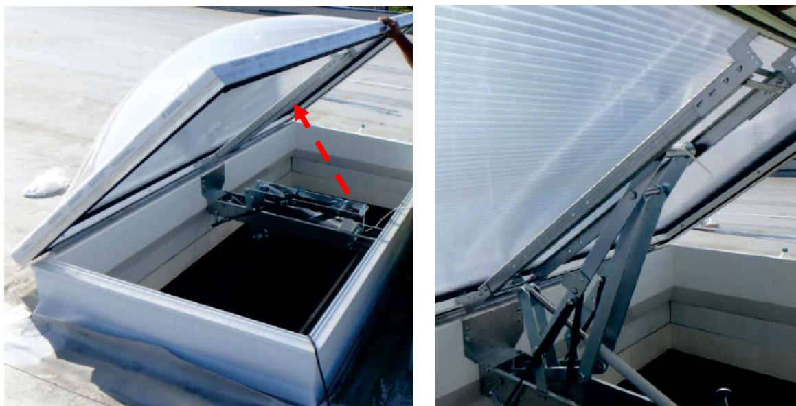
Рис. 29. Підйом ступки люка вручну та відкриття механізму до висоти траверси
