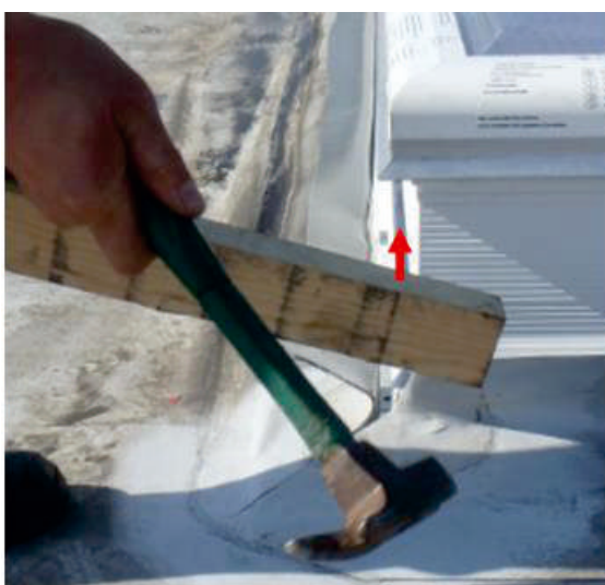
Рис. 20. Забивання з'єднання
