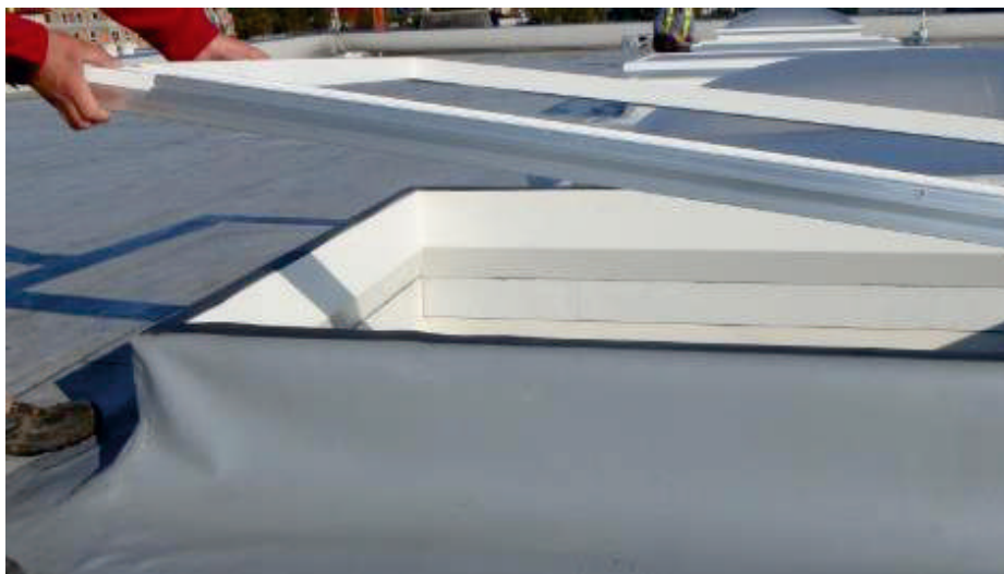
Рис. 10. Викладення притискної рами з ПВХ на ущільнення PES
